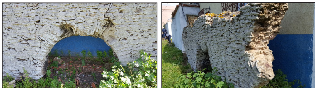
Photos montrant l'état délaissé du site AKWASS BRICHE
