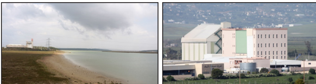
La centrale thermique de Tahaddart et l'usine des fibres
