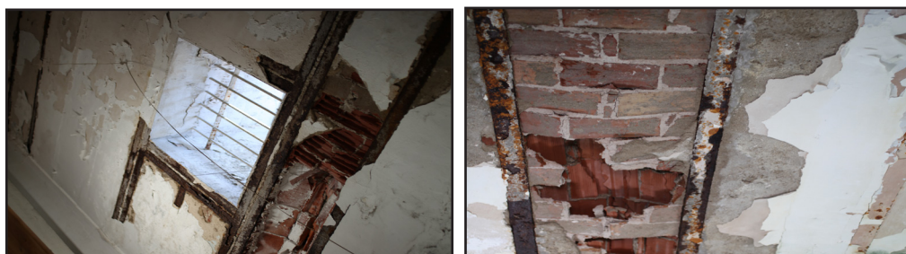
Photos montrant l'état délaissé de Dar Niyaba
